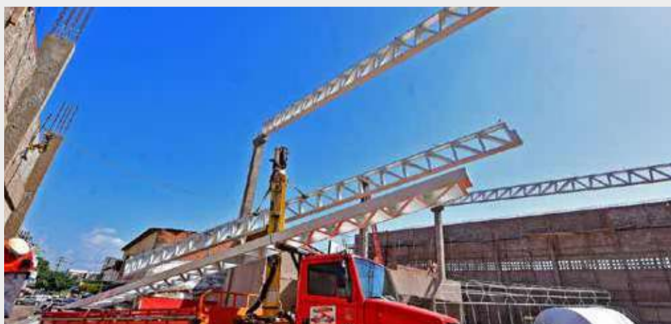
O mercado da Cohab está recebendo a estrutura metálica que dará sustentação ao telhado
